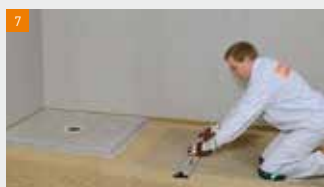
Lorsque le Mortier d'égalisation a été versé entièrement entre les bourrelets, procéder à l'égalisation
