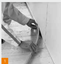
1 Pose de bande résiliente
