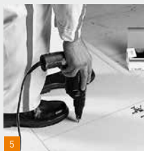
Vissage de la languette...
