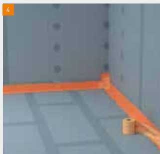
4 Appliquer le ruban isolant fermacell sur l'Etanchéité fermacell avant qu'il ne sèche.
