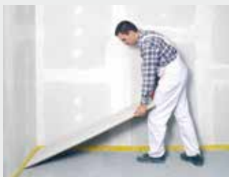
Pose des Plaques de sol
