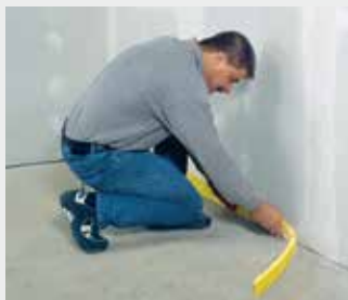
Pose des bandes d'isolation latérales
