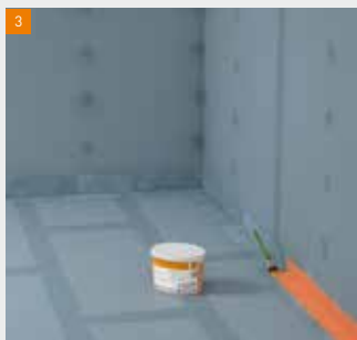
3 Appliquer la Sous-couche de protection à l'eau fermacell dans les angles.
