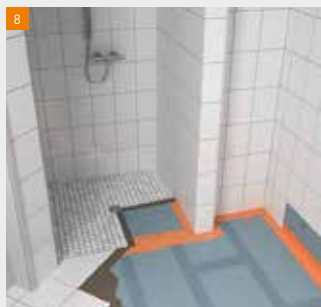
8 Si vous intégrez des Plaques Powerpanel dans une douche à l'italienne, vous devez également isoler la jointure entre la douche et le plancher contre l'humidité.
