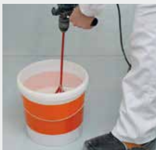
Mélanger dans un seau propre à raison de 6,5 l d'eau par sac de 25 kg
