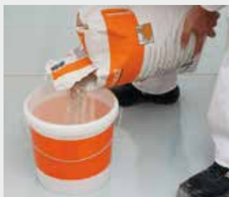
Mélanger le contenu du sac conformément aux instructions
