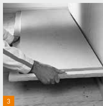
3 Pose de la première dalle
