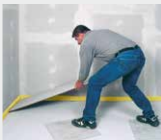
Pose des Plaques de sol
